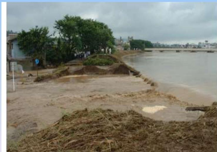
越水による洗掘破壊、すべり破壊、小崩壊が複合的に発生し、これら破壊が進行して破壊に至った可能性があります。
