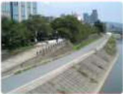
河川景観が都市景観と調和するよう、右岸バラベット部の周辺を景観的視点から改良するとともに、まちと水と緑が向き合うコミュニティゾーンの形成を図る。バラベット護岸については、石垣風に修景改良し、明治後精機の足羽川護岸を復元する。
