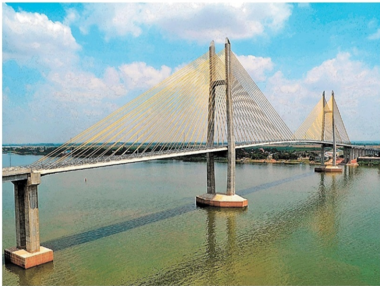
つばさ橋の全景—カンボジア・ネアックルン (三井住友建設提供)
