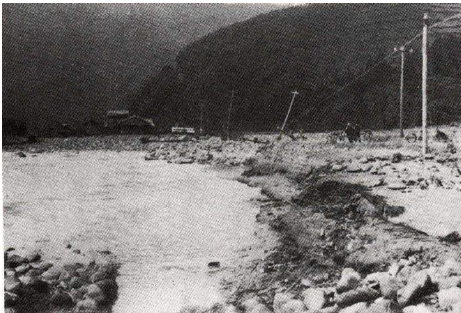
大野群和泉村朝日付近 九頭竜川右岸が破堤し、国道158号を跡形もない程に押し流
