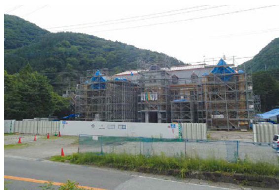
写真3 2025年開館予定の足尾銅山記念館（栃木県日光市）
